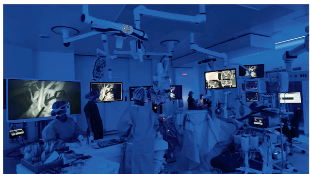
図4 手術室照明の工夫 白色光と青色光をブレンド可能な調光設計とし、ICG蛍光造影時には青色単色とすることで、モノクロの蛍光像の視認性を高めつつ、周辺スタッフの手元の作業は視認性を確保できる。
