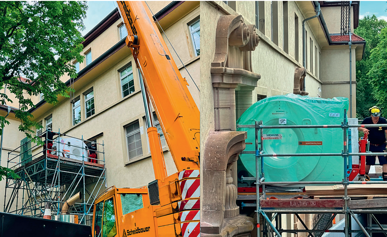
3 外壁を通して1階にMRIとCT装置を搬入している。
