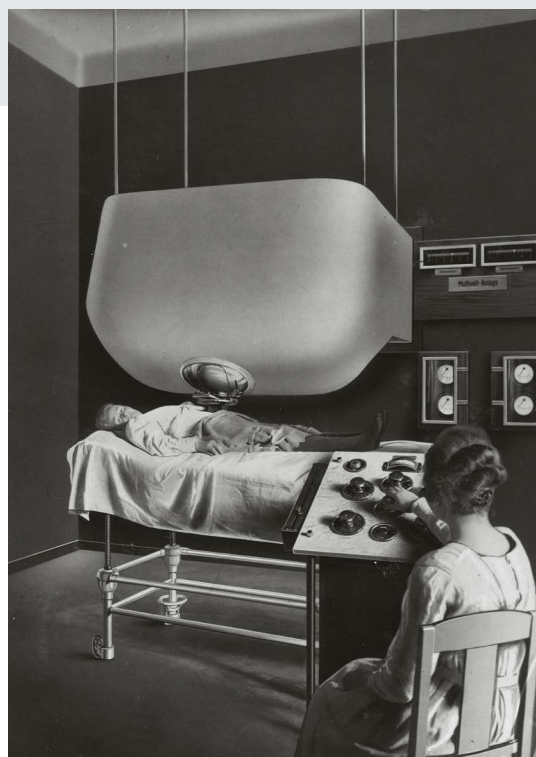
Boîte d'irradiation Siemens utilisée avec un appareil Multivolt, 1920
